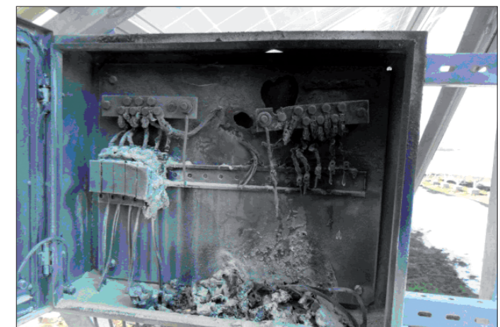
Rys. 2. Spalona rozdzielnica DC
