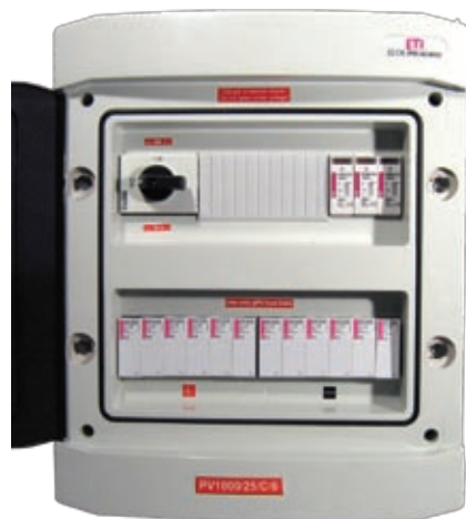
Rys. 7 Rozdzielnica PV z wyposażeniem, 24-modułowa, dla 6 rzędów szeregowo połączonych paneli PV
