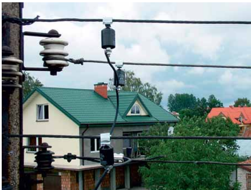
Rys. 5. Ograniczniki Etitec A z zaciskiem A na linię niez izolowaną
