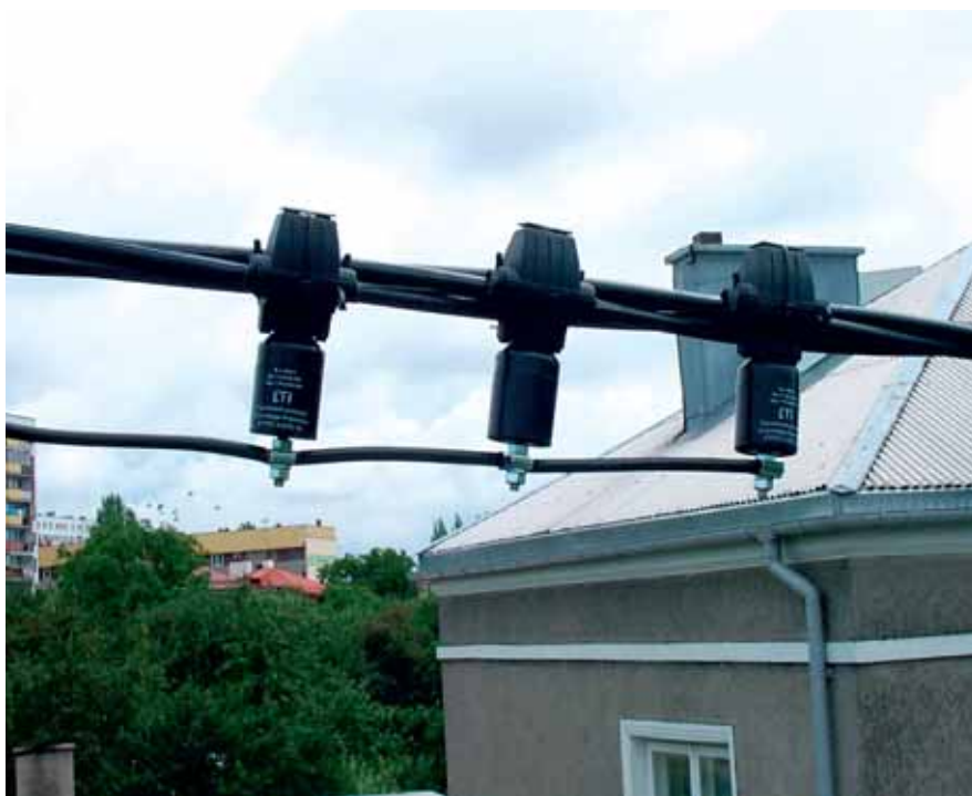
Rys. 4. Ograniczniki Etitec A z zaciskiem B na linię izolowaną
