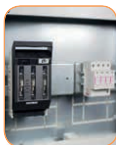
Rozłączniki LTL00 z aparaturą modułową
