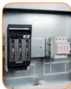
Rozłącznik LTL00 z aparaturą modułową
