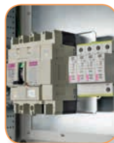
Wyłącznik EB2 160 A z aparaturą modułową
