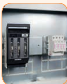
Rozłącznik LTL00 z aparaturą modułową
