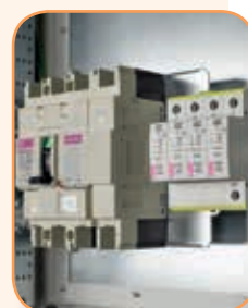
Wyłącznik EB2 160 A z aparaturą modułową
