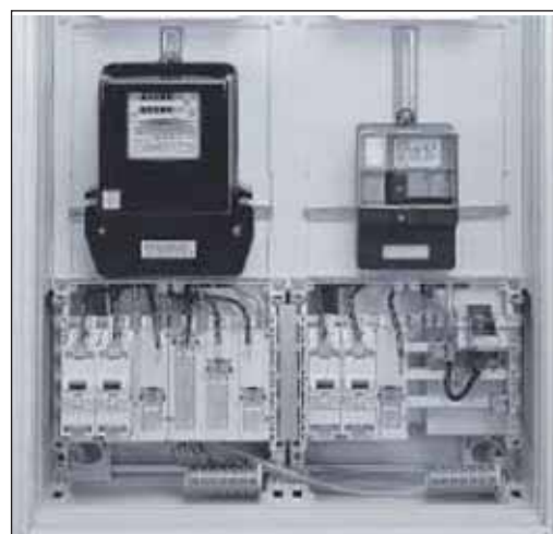
Wyłączniki ETIMAT SM zamontowane w rozdzielnicach
