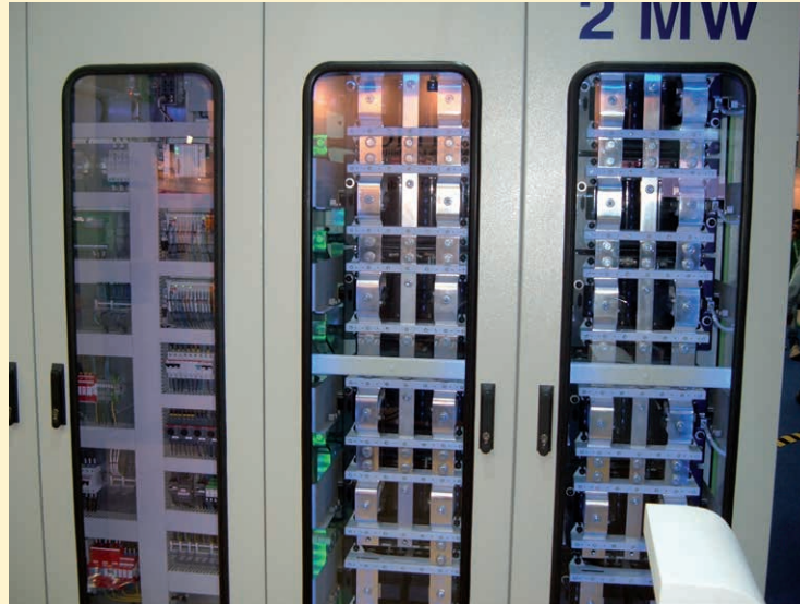
Zabezpieczenie półprzewodników wewnątrz przekształtnika średniego napięcia.
