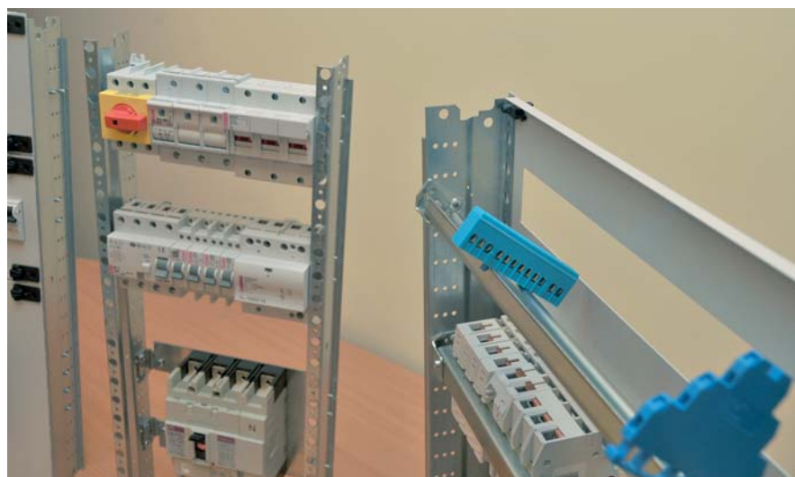
Rys. 6. Wkłady montażowe z aparaturą elektryczną
