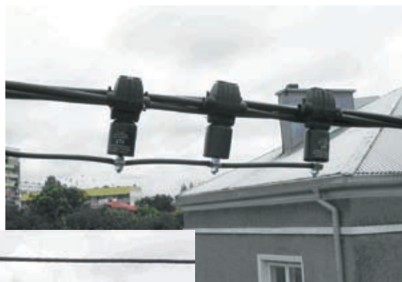
Rys. 7. Ograniczniki przepięć ETITEC A zainstalowane na linii napowietrznej nn
