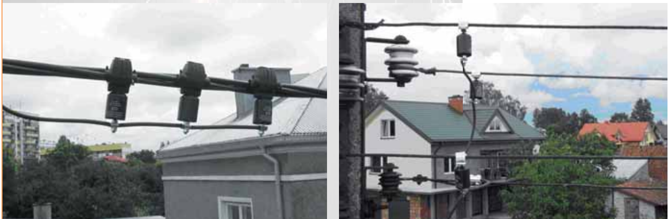
Rys. 2 Ograniczniki przepięć ETITEC A zainstalowane na linii napowietrznej nn
