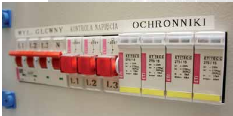
Rys. 3 Ograniczniki przepięć ETITEC C w układzie 4 + 0 zamontowane w rozdzielnicy mieszkaniowej
